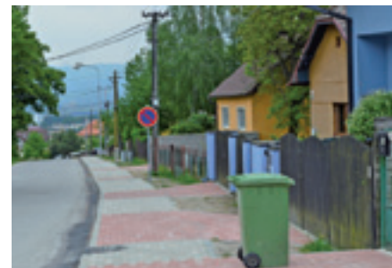
Rekonštrukcia chodníka Ul. Karvaša a Blahovca
